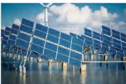
新能源 Green Energy
